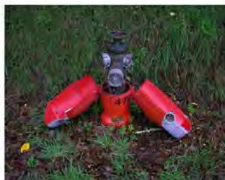
Poteau Incendie de 100 mm avec une sortie de 100 mm et deux sorties de 65 mm
