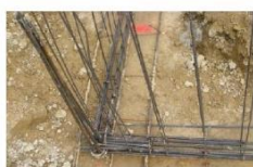
Nœud de chaînage - Continuité mécanique
