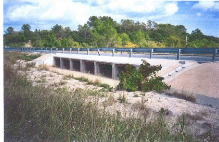
Ouvrages de décharge sous la déviation
