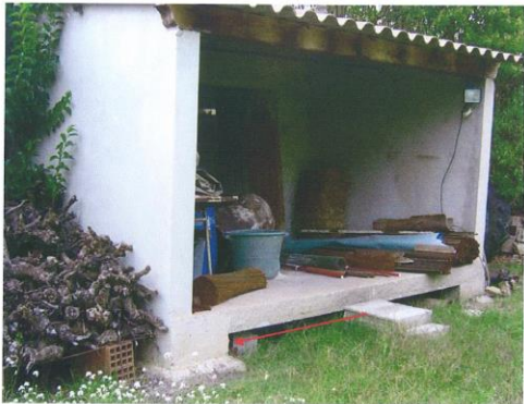
PHE n°4 au niveau du petit cabanon
