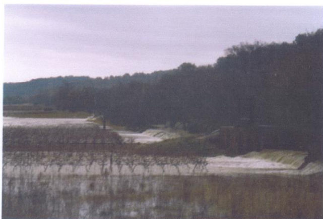
débordements rive gauche à l'aval du pont de la RD13
