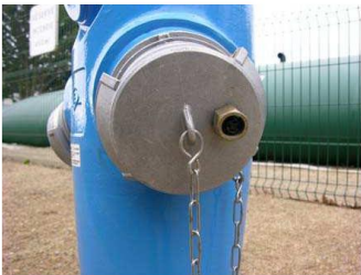
Poteau d'aspiration de 150 mm muni d'un Airclap
