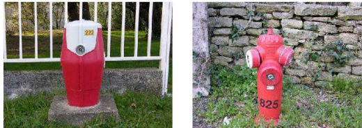
Exemples de numérotation de poteaux incendie
