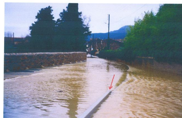
Mur de clôture à proximité du giratoire est
