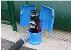
Poteau d'aspiration de 100 mm
