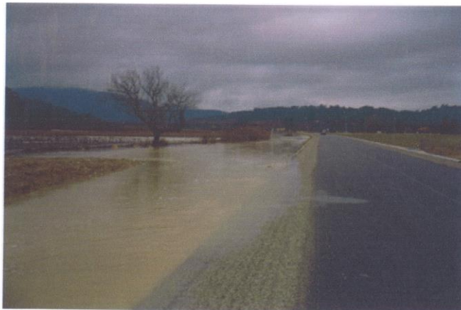
Ecoulement des eaux de débordement au sud de la déviation
