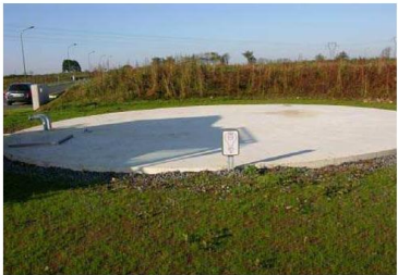
Réserve d'eau enterrée
