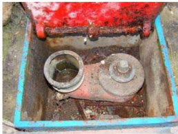
Bouche Incendie de 80 mm à raccord Keyser
