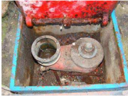
Bouche Incendie de 80 mm à raccord Keyser
