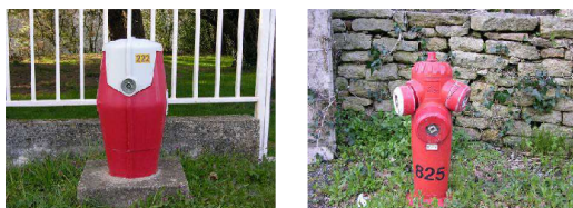
Exemples de numérotation de poteaux incendie
