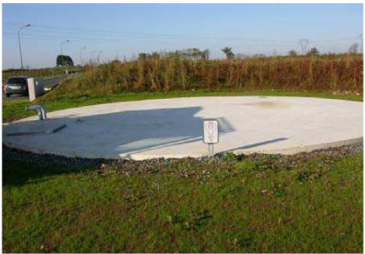
Réserve d'eau enterrée
