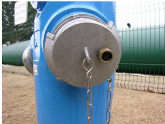
Poteau d'aspiration de 150 mm muni d'un Airclap
