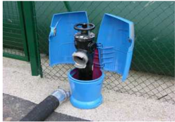
Poteau d'aspiration de 100 mm
