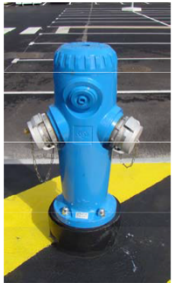
Poteau d'aspiration à réseau sec de 150 mm, muni de deux sorties de 100 mm et d'un Airclop. Pas de carré ni de volant de manœuvre
