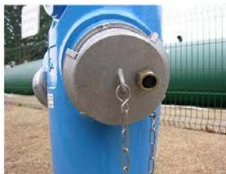
Poteau d'aspiration de 150 mm muni d'un Airclap
