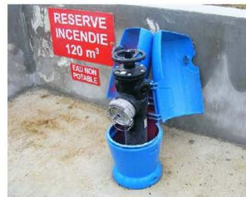
Poteau d'aspiration de 100 mm, muni d'une seule sortie de 100 mm et d'un volant de manœuvre
