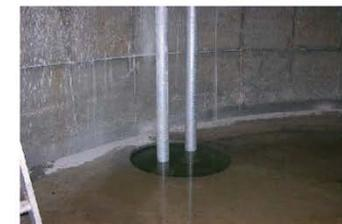
Fond de la cuve avec crépine sous le niveau le plus bas de l'eau
