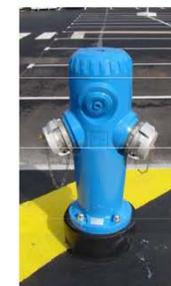
Poteau d'aspiration à réseau sec de 150 mm, muni de deux sorties de 100 mm et d'un Airclap. Pas de carré ni de volant de manœuvre
