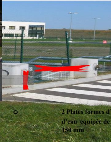
○ Plate forme d'aspiration sur une réserve d'eau équipée d'un poteau d'aspiration de 100 mm
